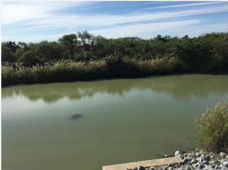
Existing Los Fresnos Levee Gap No Structure
